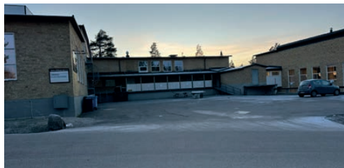
Vy över platsen där den outnyttjade byggrätten ligger belägen.
